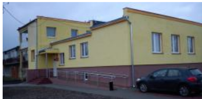
Budynek PIW po modernizacji prowadzonej w latach 2012-2013
