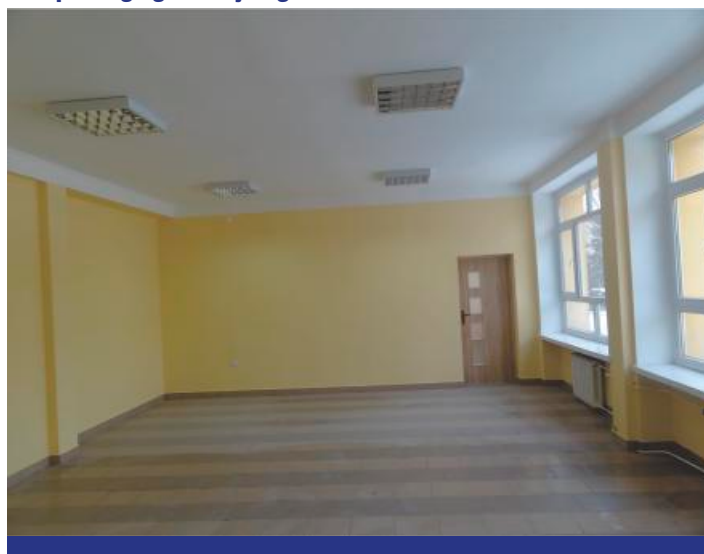
20. LO w Sępólnie Krajeńskim – przeniesienie szatni i remont pomieszczeń dla biblioteki pedagogicznej – grudzień 2015
